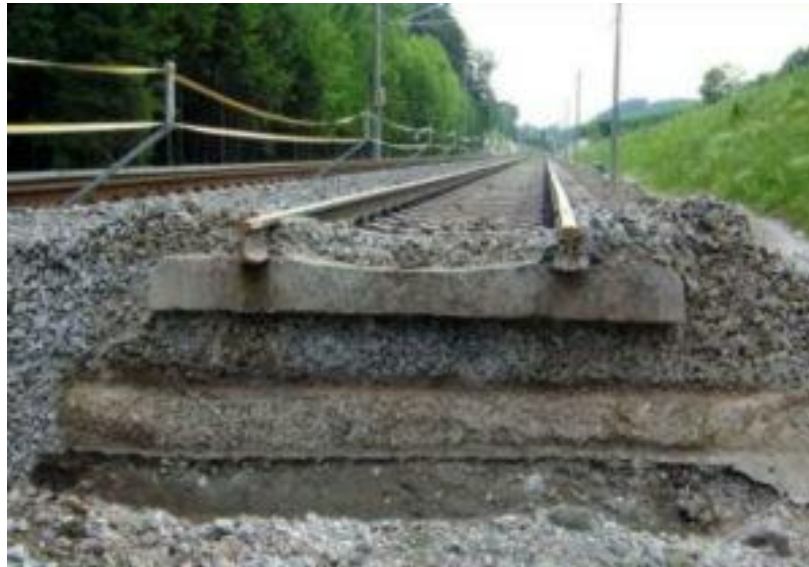
Рисунок 1. Разрез балласта
